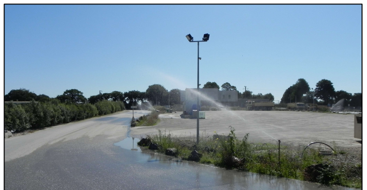
Photo n°8: Vue sur le réseau d'asperseurs (SAS GUENA)
