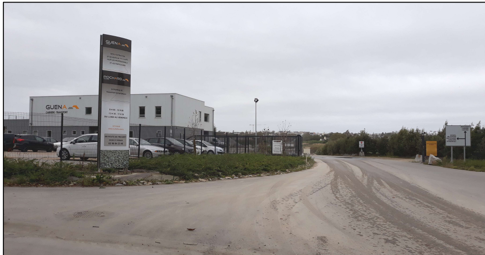
Photo n°4: Vue sur l'entrée-sortie de la SAS GUENA sur la VC n°1
